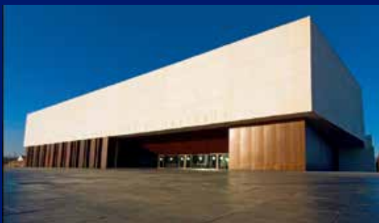
AUDITORIO/PALACIO DE CONGRESOS CASTELLÓN Avenida del Lledó, 50, Castellón.
